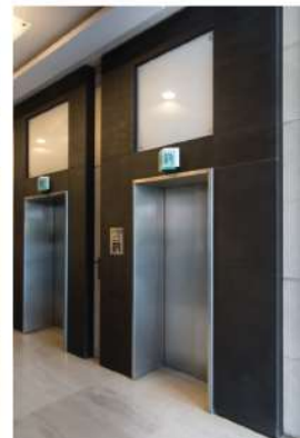
על מנת שארונות השירות והבקרה לא יפגמו במראה המכובד, הם נבנו בישורת מושלמת
